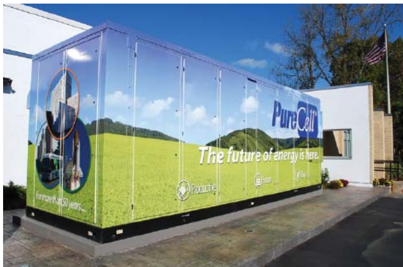
Şekil 3 400kWe Kapasitesine sahip FAYP tipi yakıt pili [6]
