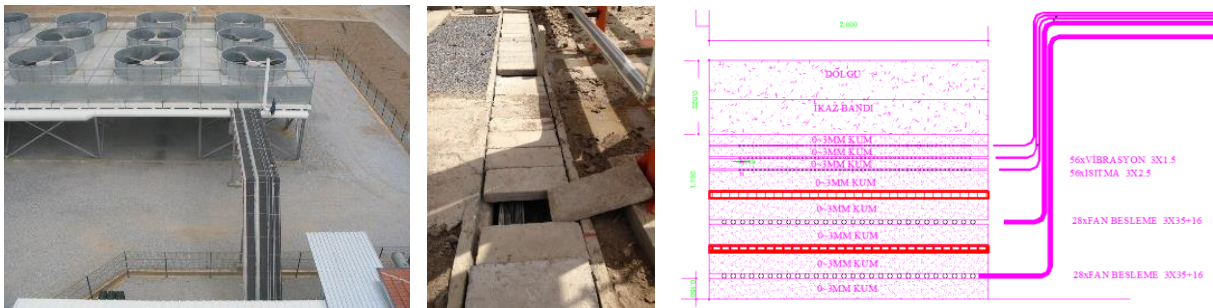
Şekil 3.2 Kablo Güzergahı a) Kontrüksiyon b) Galeri c) Gömülü
