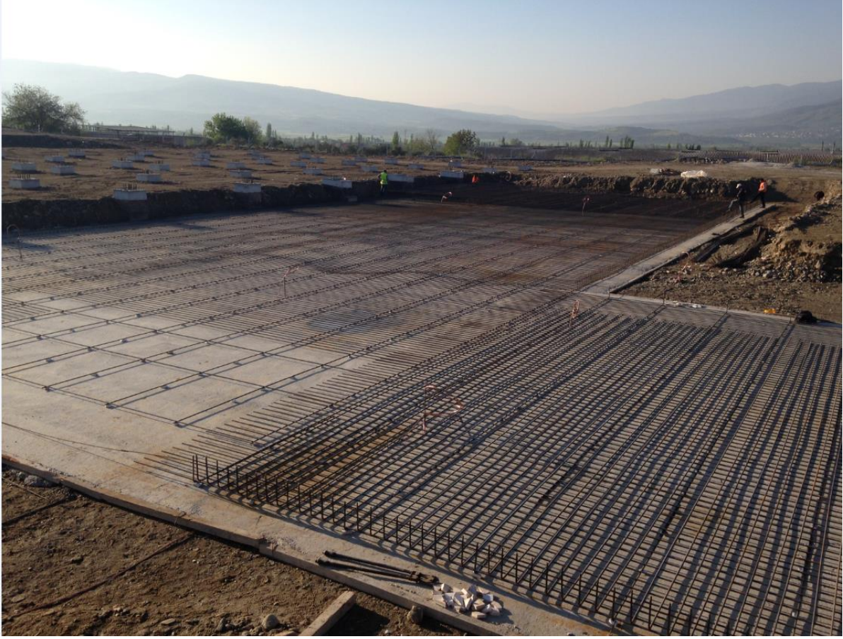
Şekil 4.2 ACC ve ORC grubu radya temel projelerininine ait bir fotoğraf
