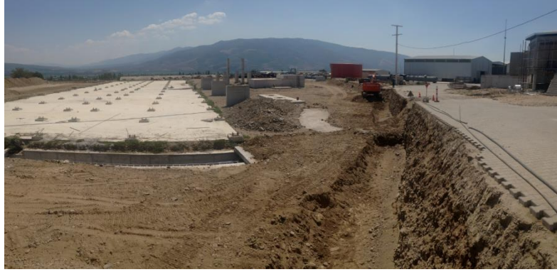
Şekil 3.3 Kablo güzergahı çıkış noktası Galeri tip
