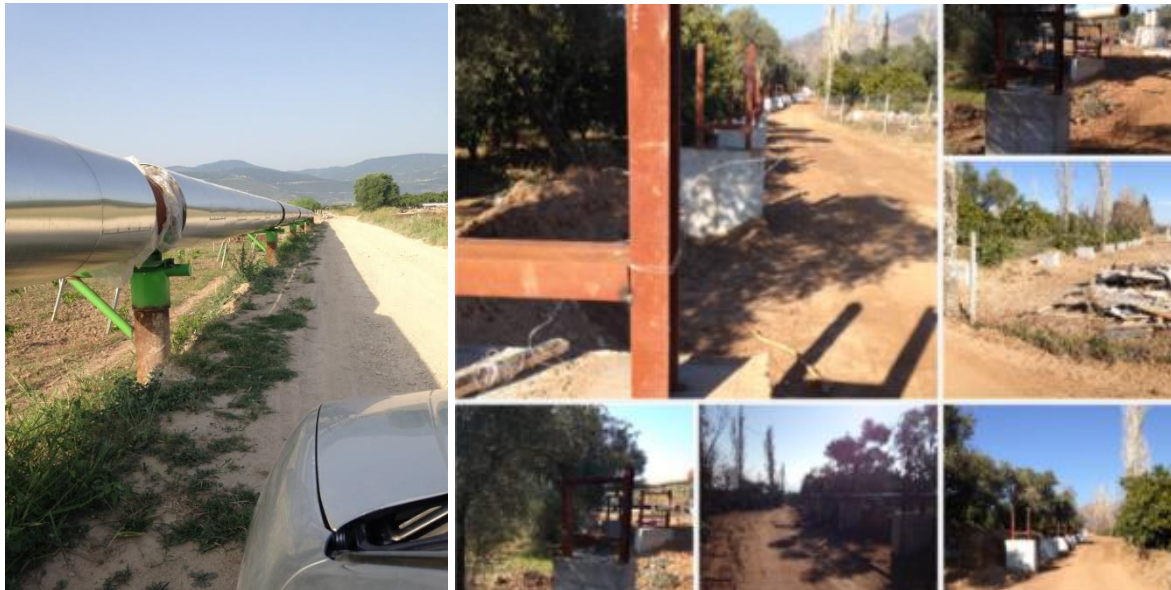
Şekil 4.7 Direk tip ve Betonarme tip support detayları
