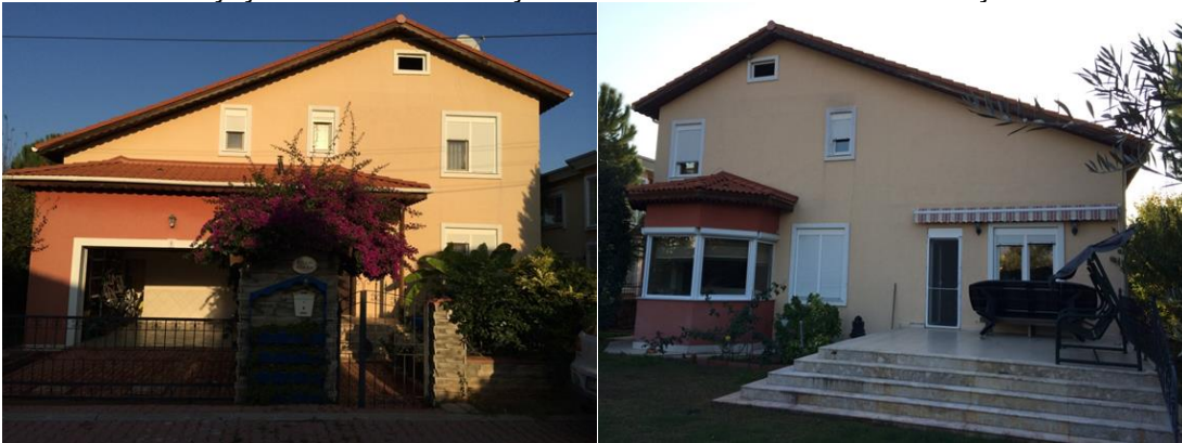
Şekil 3. Ön cephe – Arka cephe
