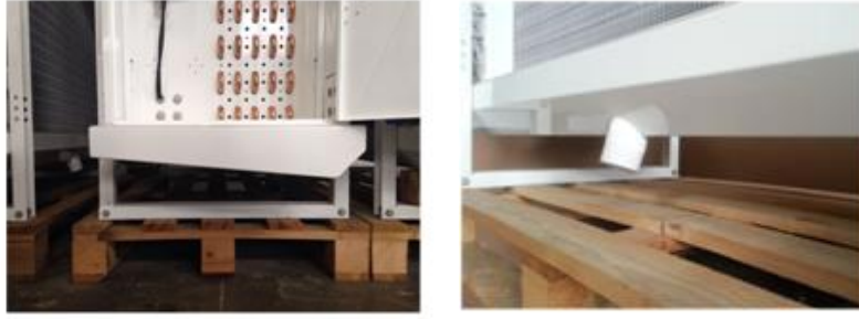
Şekil 9. Yeni tarz evaporatörlerde drenaj tavası yapısı
