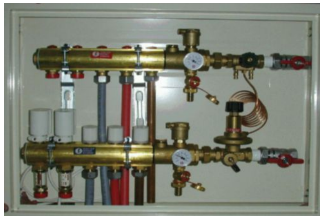
Resim 5. Yerden Isıtmada Fark Basınç Vanası Uygulaması [9]
