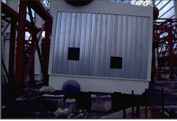
Şekil 4. Deprem koruması olmayan bir kazanın deprem sonrasındaki hasar oluşumu
