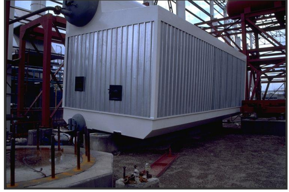
Şekil 4. Deprem koruması olmayan bir kazanın deprem sonrasındaki hasar oluşumu
