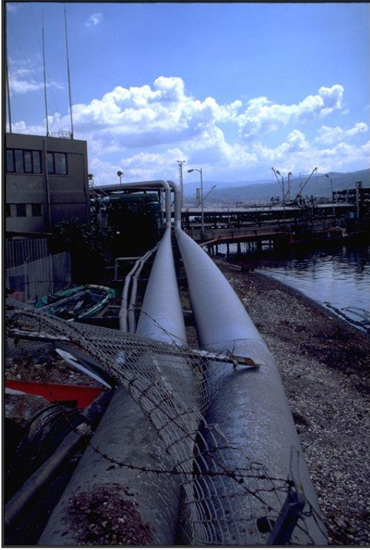
Şekil 6. Deprem koruması yapılmamış bir tesisat hattının deprem sonrasındaki hasar oluşumu
