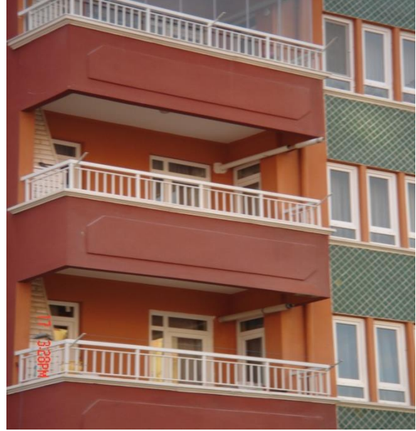
Şekil 1. C tipi denge bacalı (hermetik) aygıtların atık gaz çıkışlarının dış cephede düzenlenmesi
