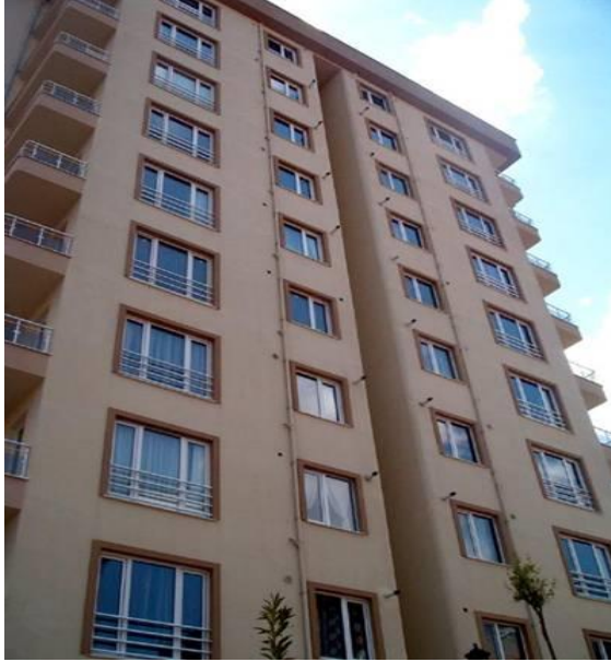
Şekil 1. C tipi denge bacalı (hermetik) aygıtların atık gaz çıkışlarının dış cephede düzenlenmesi
