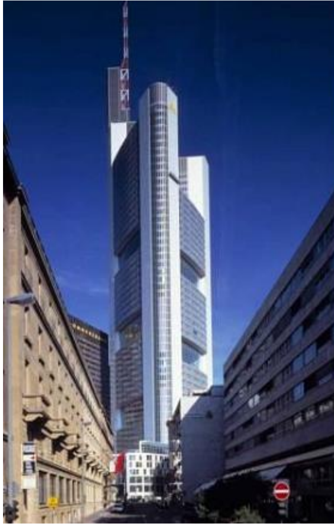
Şekil 3. Commerzbank Binası, Almanya, dış görünüş (1997) [8].
