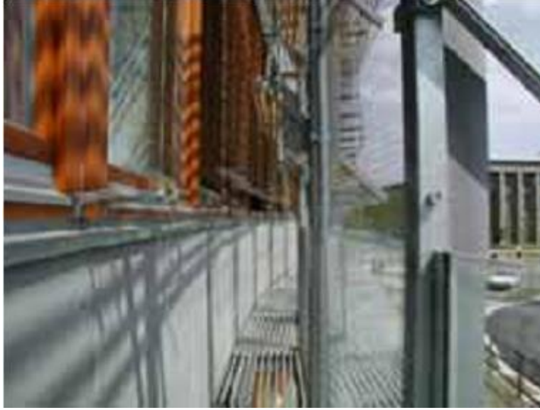
Şekil 8. Moravian Kütüphanesi, Çek Cumhuriyeti, çift cidarlı cephenin kavitesi ve güneş kırıcılar (2001) [9].
