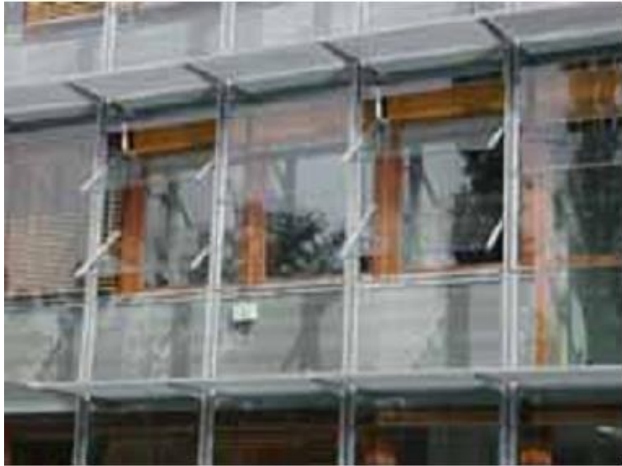
Şekil 7. Moravian Kütüphanesi, Çek Cumhuriyeti, açılabilir pencere cephe (2001) [9].
