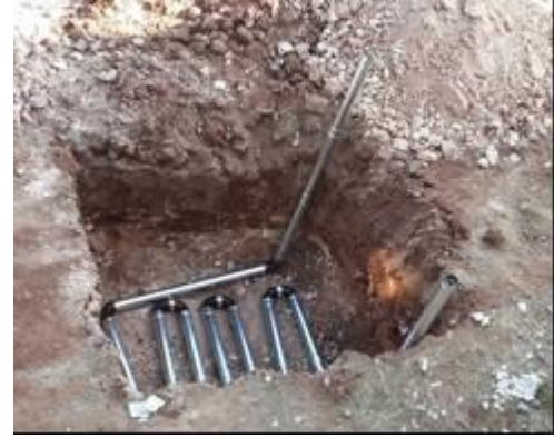
Şekil 4. THID sisteminde boruların yerleştirilmesi
