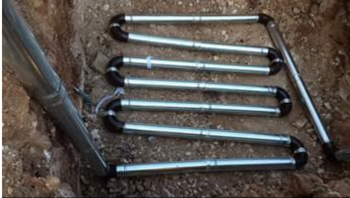
Şekil 4. THID sisteminde boruların yerleştirilmesi
