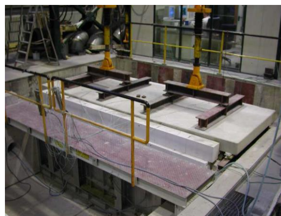
Resim 6. Isı Yalıtım Plağı Kaplanmış Betonarme Tavanın Üstten Görünüşü [12].
