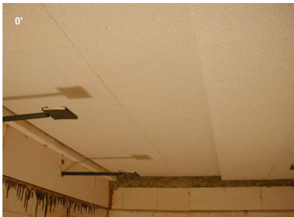
Resim 5. Isı Yalıtım Plağı Kaplanmış Betonarme Tavanın Alttan Görünüşü [12].
