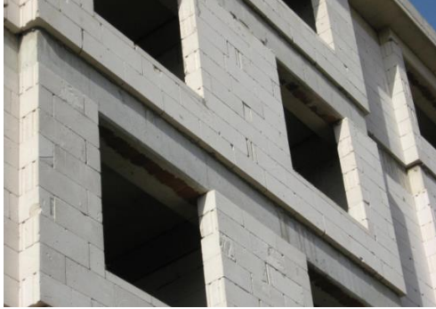
Resim 1. Taşırılarak Örülen Gazbeton Duvarlar
