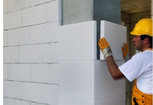
Resim 2. Gazbeton Isı Yalıtım Plakları ile Betonarme Yüzeylerin Kaplanması
