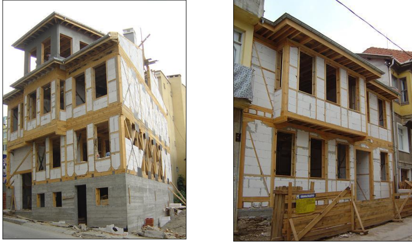
Şekil 1. 2. Restorasyonu gaz beton blok ve beton kullanılarak yapılan temsili geleneksel konutlar
