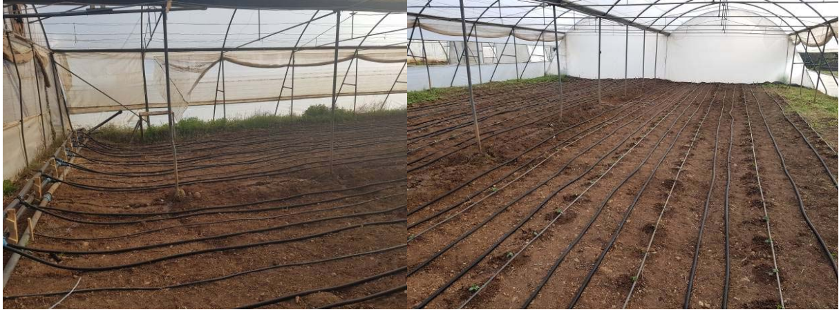
Şekil 5. Plastik serada plastik borulu ısıtma sistemi
