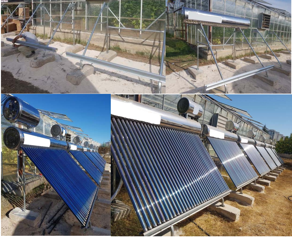
Şekil 2. Vakum borulu toplaçlarından oluşan ısı toplama ünitesi
