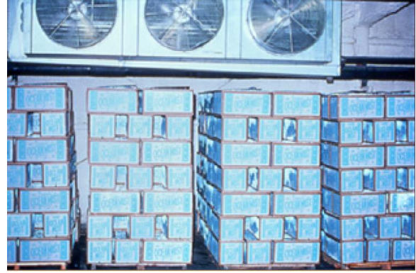
Şekil 7. Odada önsoğutma çalışma prensibi, seyrek istifli yerleşim. [5, 13].
