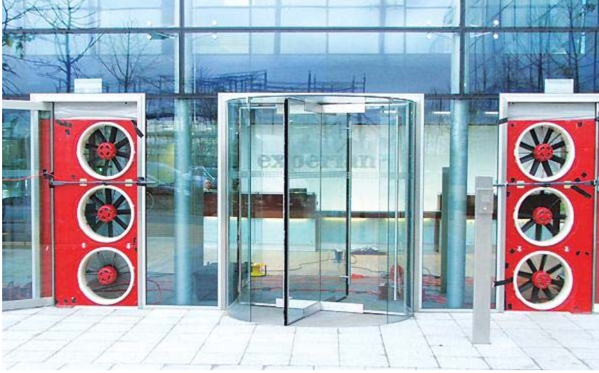
Tüm bina hava geçirimsizlik testi (ASTM E 779)
