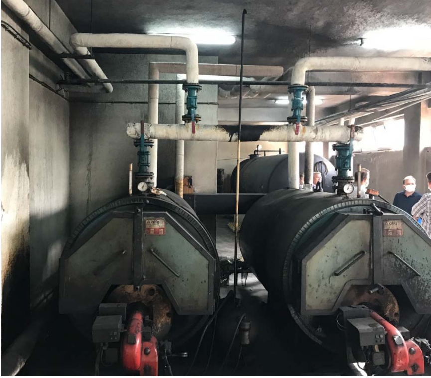
Şekil 3. Eski Isıtma Sistemi Kazan ve Brülör Kollektör Görüntüleri
