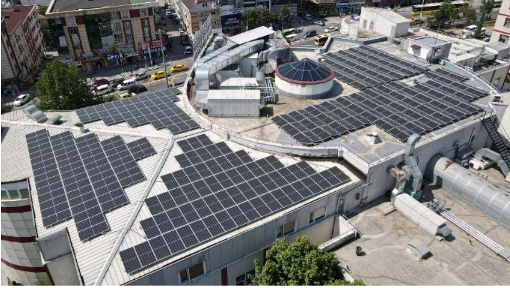
Şekil 6 İstanbul Esenyurt Necmi Kadioğlu Devlet Hastanesi Enerji Verimliliği Uygulamaları ve Çatı Üstü Güneş Enerjisi Santrali Uygulaması
