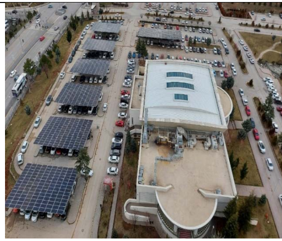
Şekil 4 Tarım ve Orman Bakanlığı Açık Otopark 400 KW Güneş Enerjisi Santrali Uygulaması
