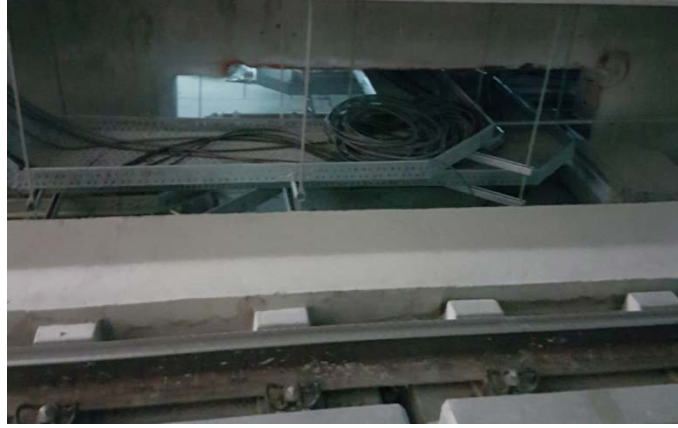
Şekil 6. Tünel İçerisindeki Açıklıklar
