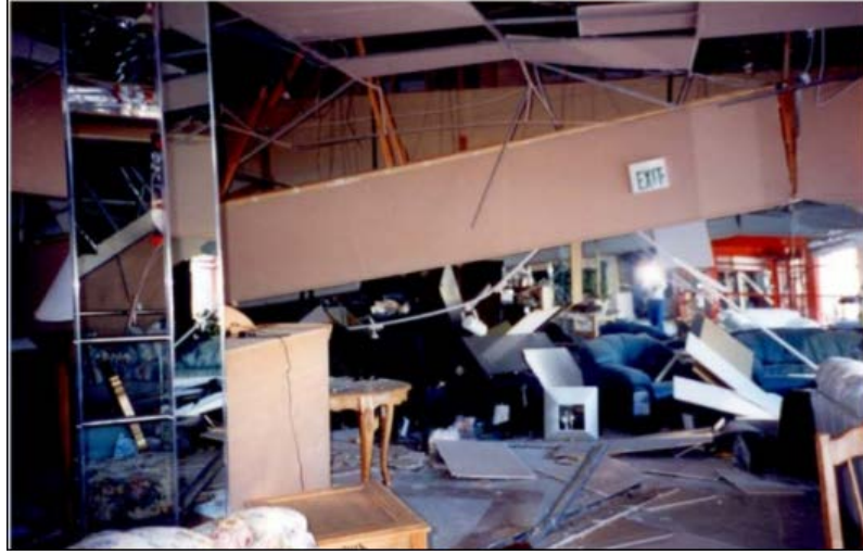
Resim 2. Mobilyaların devrilmesi ile oluşan hasar, Northridge 1994 [3]
