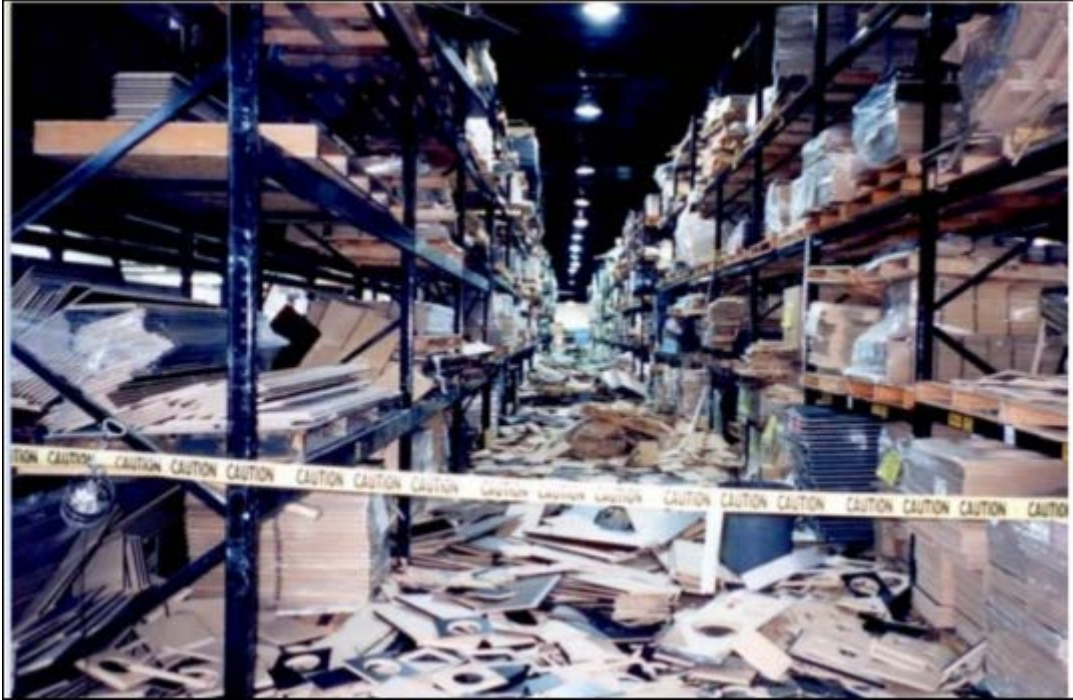
Resim 3. Depo tesislerinde meydana gelen raf hasarı, Northridge 1994 [3]
