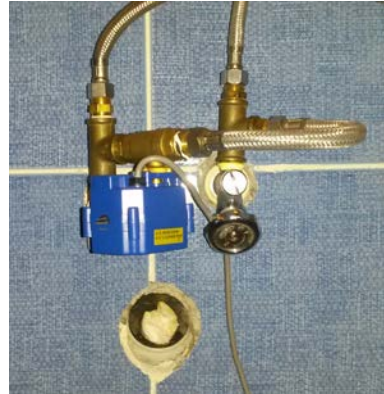
Şekil 36. Lavabo altı by-pass valf
