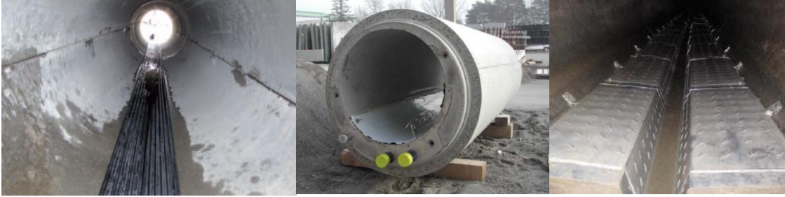
Şekil 8. Kanal yatağına yerleştirilmiş ısı değiştiricisi uygulamaları [16,17-18]
