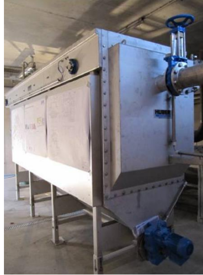
Şekil 10. Pompa-filtre sistemli harici ısı deęiřtiricisi uygulaması [19]
