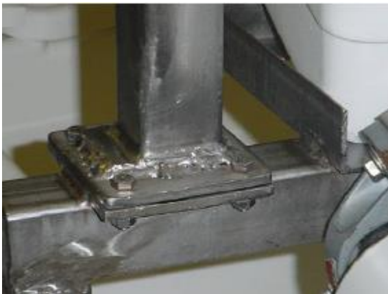
Şekil 6. Uygun olmayan bağlantı elemanı ve kaynak çözümleri [5].
