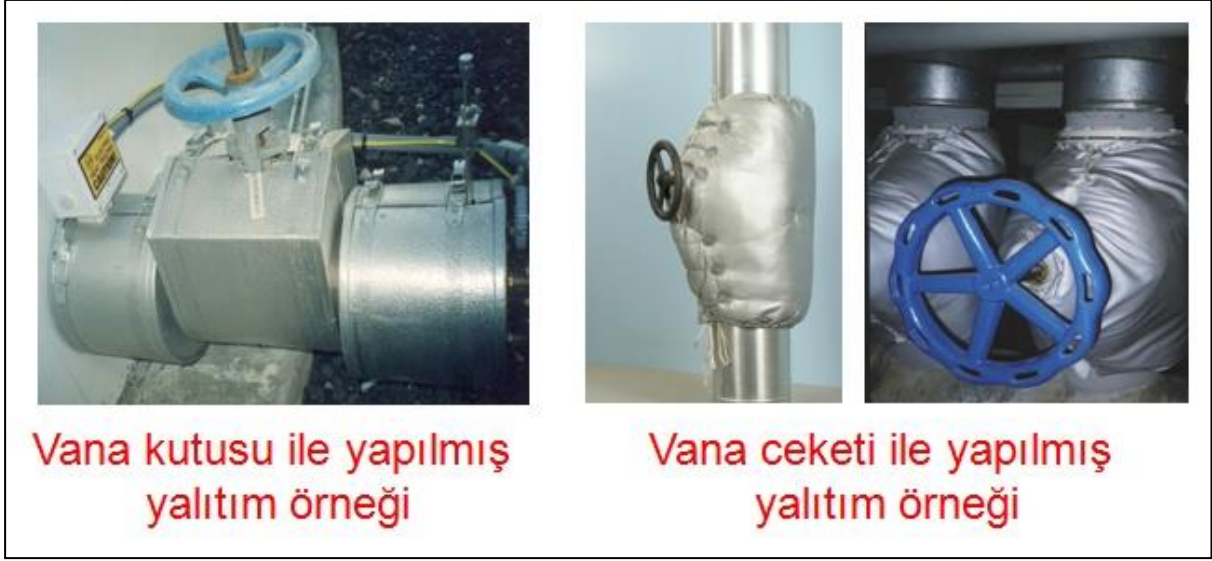
Şekil 12. Vana kutusu ve vana ceketi ile yapılmış yalıtım örnekleri
