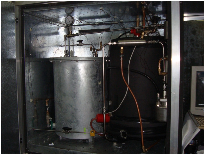
Şekil 3 Isı Değiştirici Kabini
