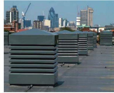
Tam otomatik veya ayarlanabilir elemanlarla havalandırma sağlayan Rüzgar Bacaları [29,30].
