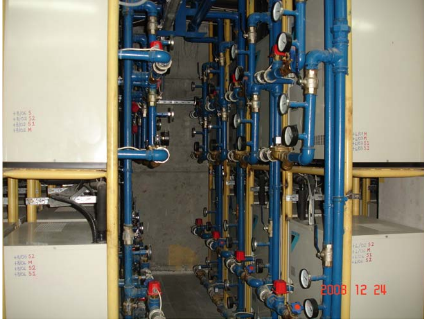
Şekil 10. AVM Kazan Dairesinde Dış Ünitelerin Yerleşim Görüntüsü
