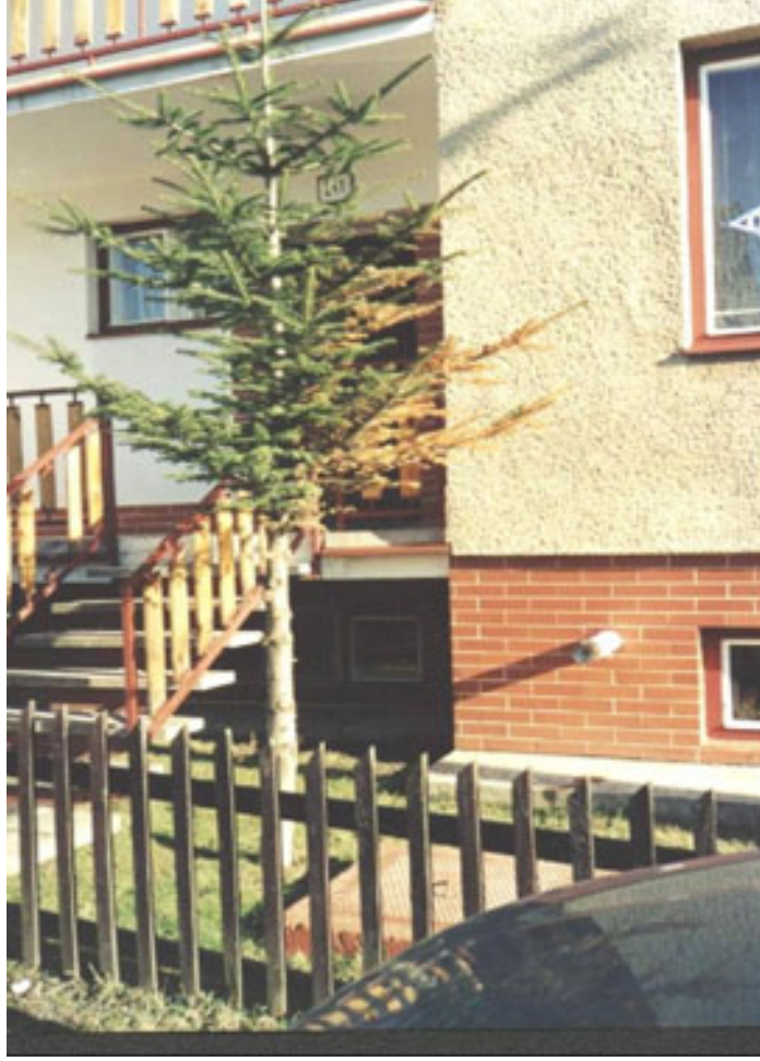
Şekil 93. Klasik hermetik cihazın bacasından çıkan atık gazın, atık gaz ile çevre arasındaki etkileri görülmektedir.
