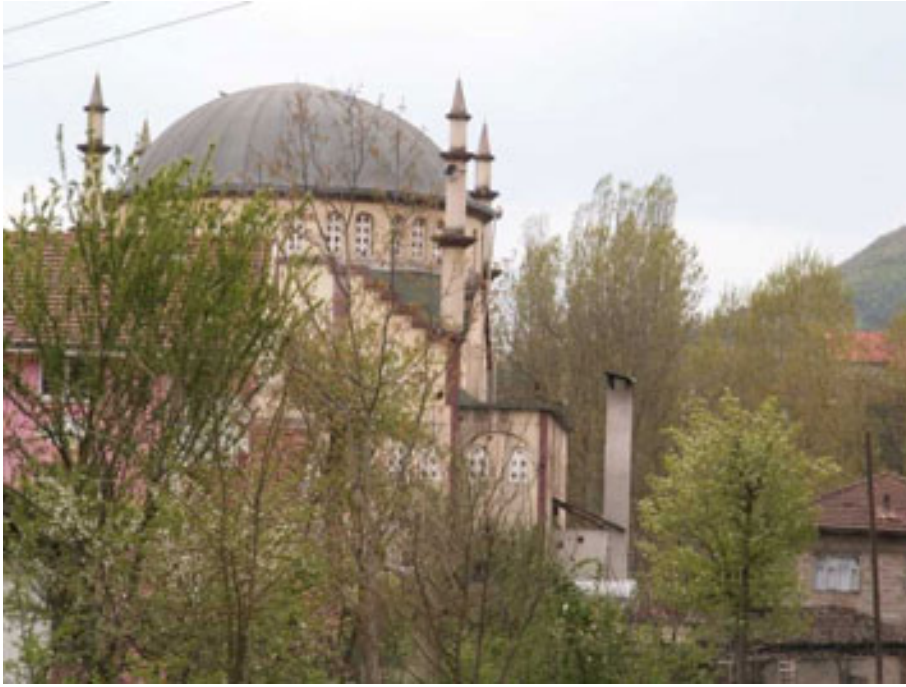
Şekil 68. Yersiz baca yükseklikleri ve izolasyon bacalarda çekiş sorunlarına neden olmaktadır.
