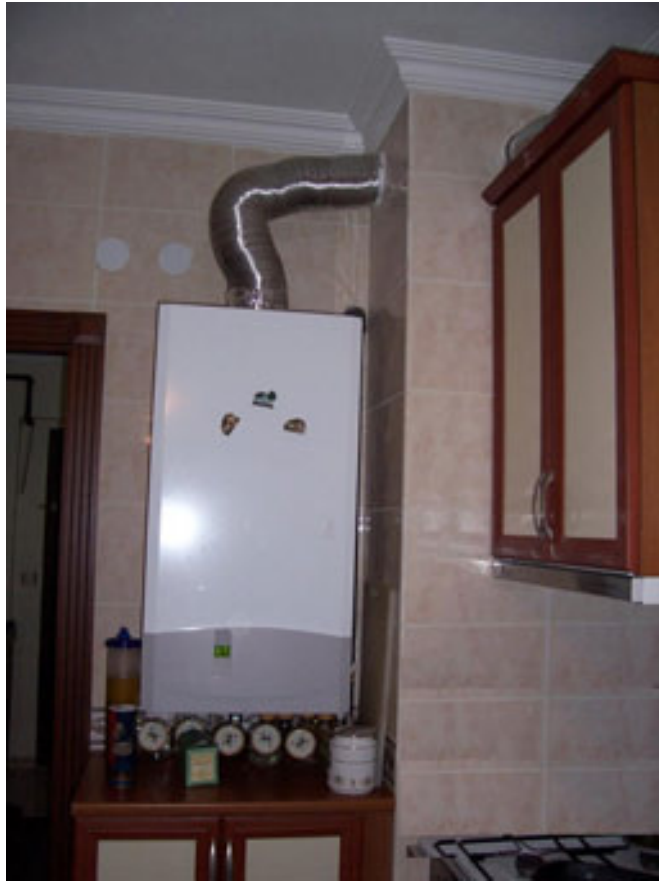
Şekil 51. Keskin dirsekler ve hızlandırma parçasına dikkat edilmeksizin yapılan bir montaj örneği.
