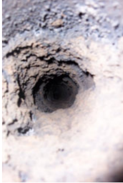
řekil 49. Yetersiz baca ekiři sebebiyle oluřan bozuk yanma ve sonucunda kurum dolarak tıkanmıř bir baca.
