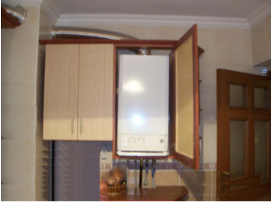
Şekil 50. Gereğinden uzun tutulan yatay mesafe ve hızlandırma mesafesine dikkat edilmeden yapılan bir uygulama.
