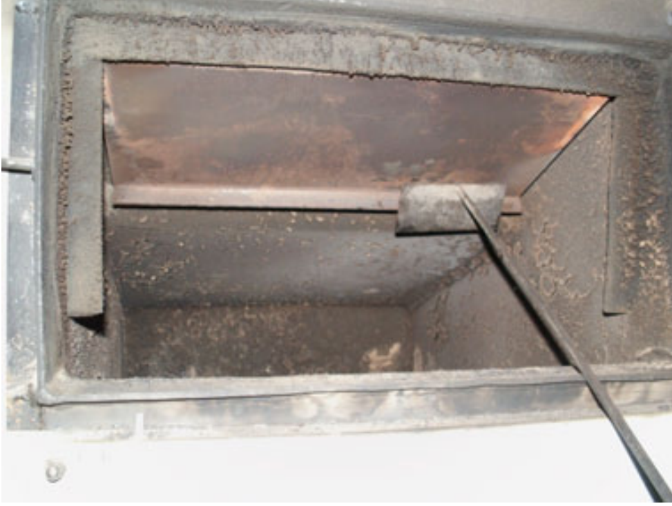
řekil 48. Yetersiz baca ekiři yanma veriminin dřmesi ve kurumlanmaya sebep olacaktır.
