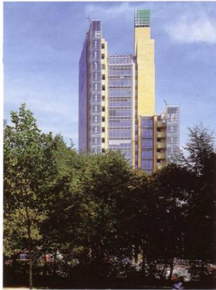
Şekil 11. Berlin Debis Binası ve Çift Cidarlı Cephe Uygulaması
