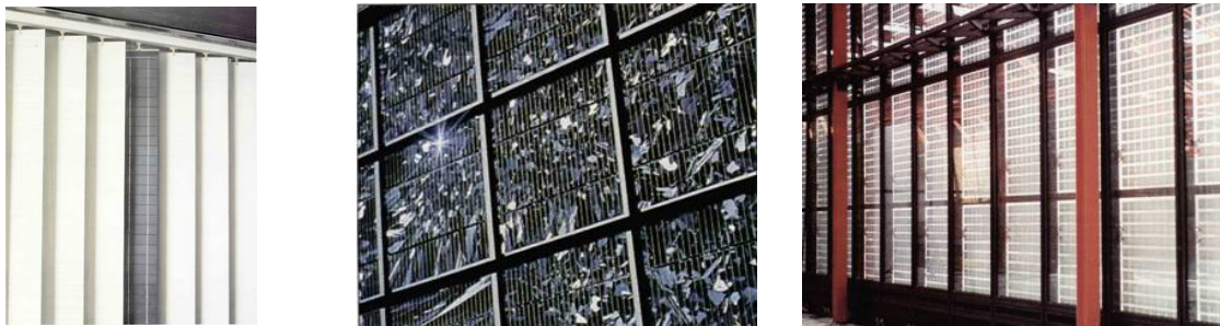
Şekil 13. Güneş Kontrol Elemanı ve Cephe Kaplaması Olarak PV Paneller
