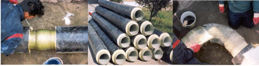
Şekil 1. Filament sarma tekniği ile üretilmiş cam-fiberle güçlendirilmiş poliester kompozit borularının adhezyonla birleştirilmesi.
