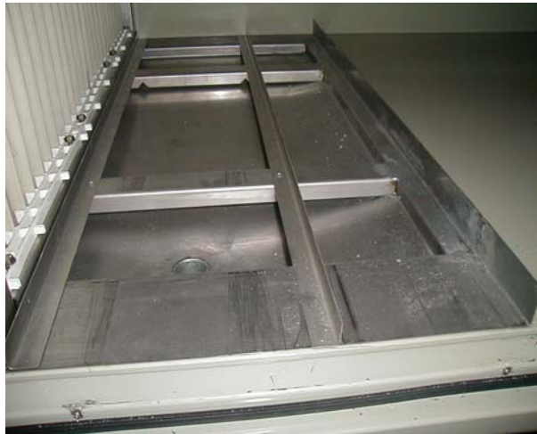
Şekil 6. Hijyenik uygulamalarına uygun çift eğimli yoğuşma tavası
