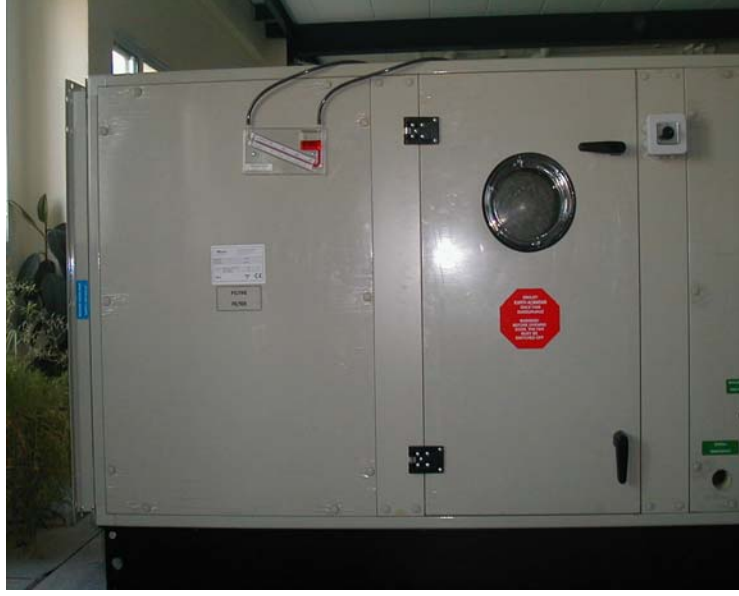
Şekil 4. İkinci filtre, konulan basınç farkı manometresi, hücre tanımlama ve filtre ile ilgili gerekli bilgiler
