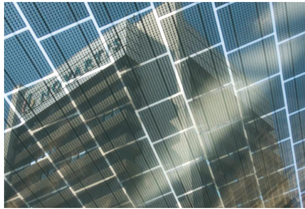
Şekil 4. Novartis Gehry Binasında Kullanılan PV Bileşenlerin İç Mekandan Görünümü [7]
