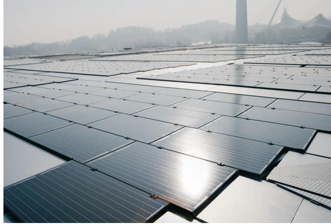
Şekil 7. BMW World Binası'nın Çatısından Detay [9]
