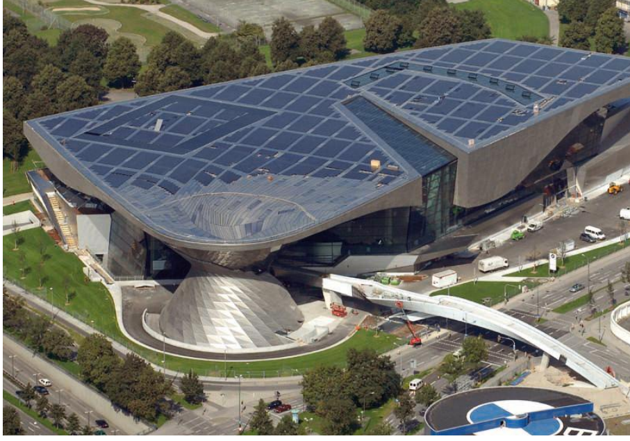
Şekil 6. BMW World Binası'nın Çatısının Görünüşü [9].
