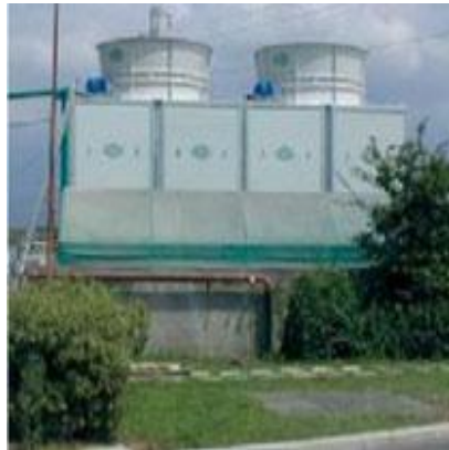
Şekil 4. Açık Tip Soğutma Kulesi
